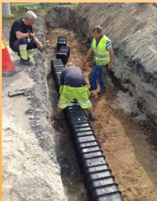
Installasjon/montering av multikanalene
