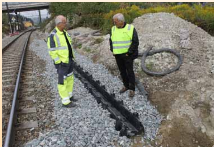
Bjørn Hagen (til venstre) hos Jernbaneverket og Stig Adolfsen hos Melbye ser på installasjonen.
