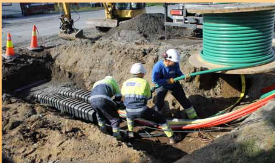
Installasjon av subrør og kabel
